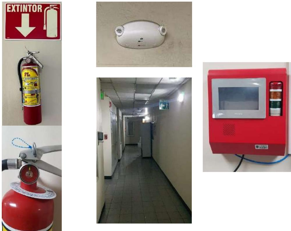
Figura 66. Instalaciones de extintores, luces de emergencia y alarma sísmica.
