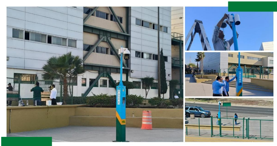
Figura 67. Torre de seguridad instalada en FCA Mexicali.
